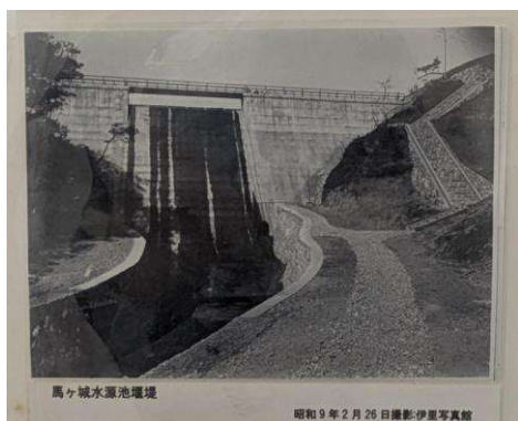
完成直後の堰堤
