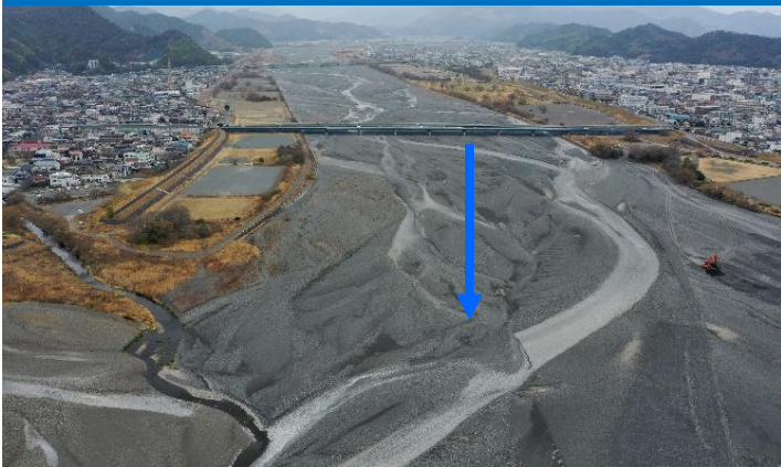
瀬切れ: 狩野橋上流(令和8年2月24日)
