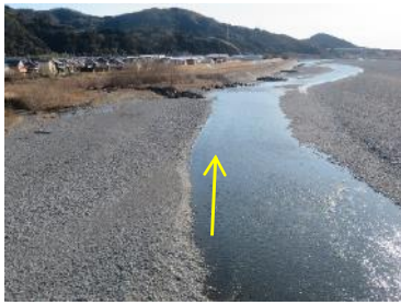
大井川用水水路橋下流(21.0km付近)(1月26日)
