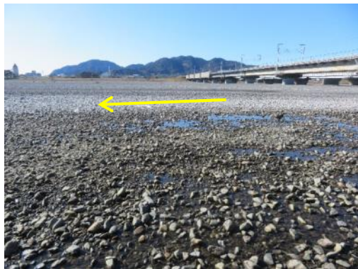
②安倍川橋梁 (JR東海) 下流付近 (3.63km) 令和5年1月26日の様子
