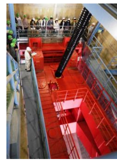
長島ダム内部見学
