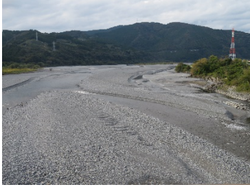
大井川用水水路橋上流(21.0km付近)(10月27日)
