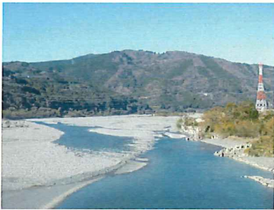
大井川用水水路橋上流(21.0km付近)(12月25日)
