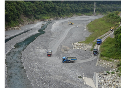
堆砂掘削工事の様子
