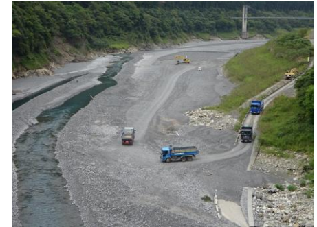
堆砂掘削工事の様子
