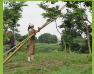
河道内樹木伐採作業
