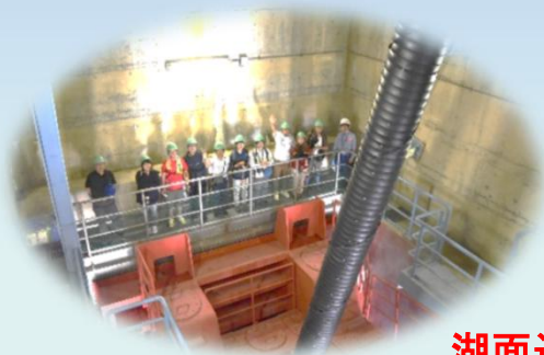
長島ダム内部見学(コンジットゲート)
