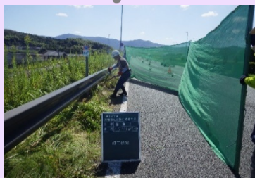
法面の除草作業
