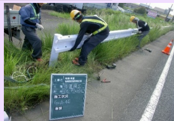
防護柵の復旧作業
