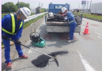
路面の凸凹補修作業
