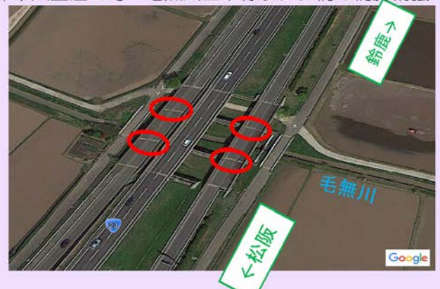
津市大里窪田町 毛無川上下線ランプ橋の橋脚補強
