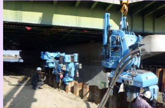
鋼矢板を切断しながら引抜いていきます。
