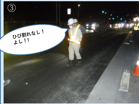
異常がないか点検しています。
