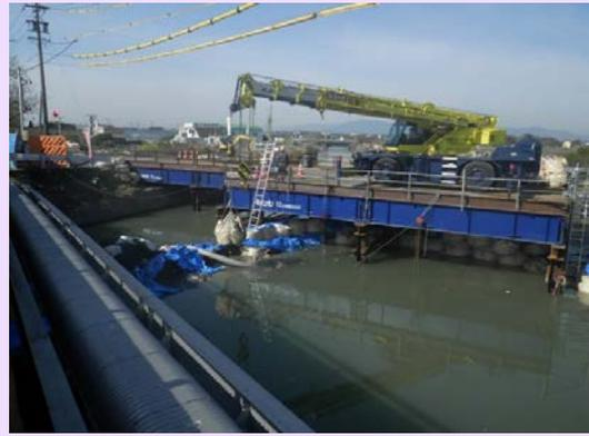
河川内の大型土のう袋の仮締切を撤去しています
