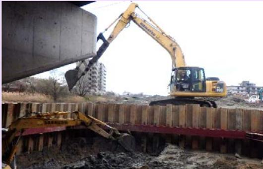
通常の機械に長いアームを付けて作業しています。
