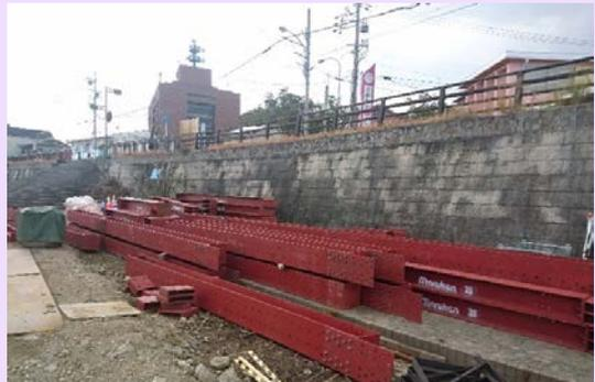
鋼矢板が倒れないように鋼製の梁を設置します。
