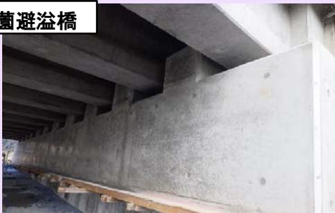
沓座拡幅コンクリート打設完了
