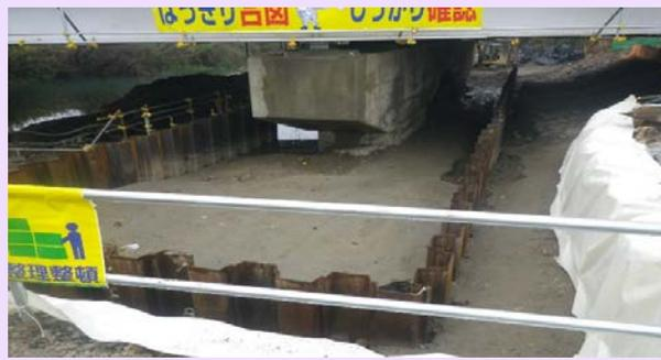
国道23号南勢バイパスにおきまして橋梁耐震補強工事をしています南建工業株式会社です。工事は新祓川橋の左岸側の橋脚まわりに仮設の鋼矢板を打設し、橋脚巻立て補強を行います。3月は鋼矢板の打設を再開し、仮設工が終わったら橋脚補強工事の材料や機械を運搬する車が出入りする予定です。沿線及び地域住民の皆様にはご迷惑をお掛けすることとなりますが、ご理解とご協力のほどよろしくお願い致します。
