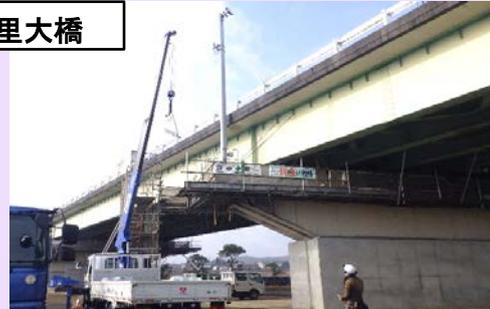
落橋防止装置施工状況
