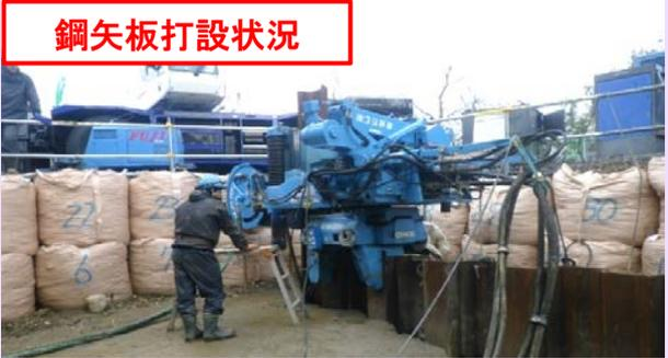
国道23号南勢バイパスにおきまして橋梁耐震補強工事を行っています南建工業株式会社です。工事は新祓川橋の左岸側の橋脚まわりに仮設の鋼矢板を打設し、橋脚巻立て補強を行います。2月も鋼矢板の打設を施工し、仮設工が終わったら橋脚補強工事の材料や機械を運搬する車が入り出す予定です。工事中は、沿線及び地域住民の皆様にはご迷惑をお掛けすることとなりますが、ご理解とご協力のほどよろしくお願い致します。
