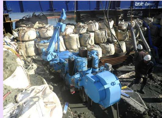
この機械で橋に鋼矢板を圧入していきます。
