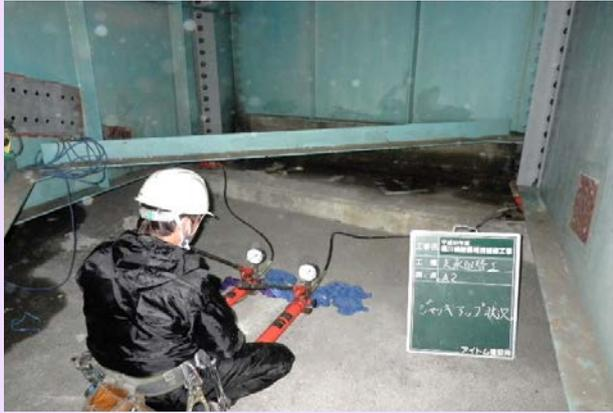
支承受替工 旧支承受壊し撤去
