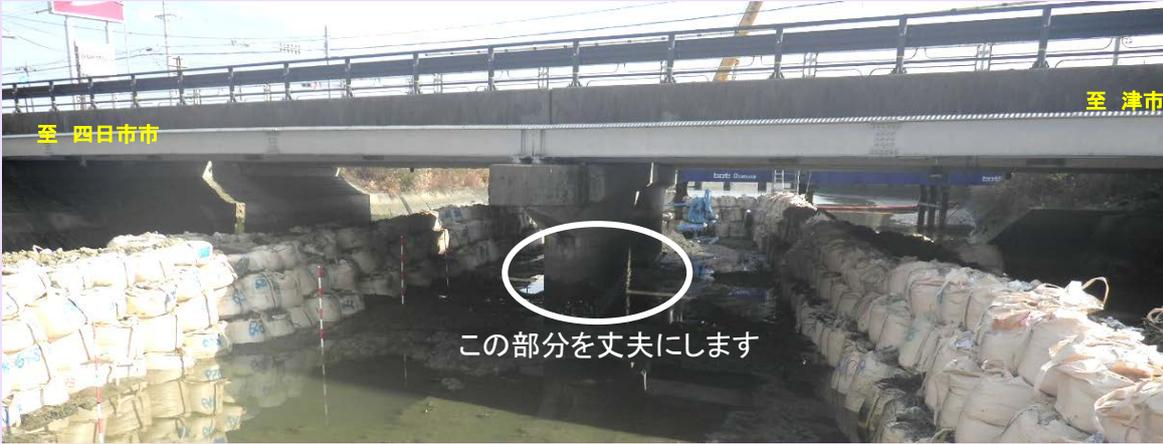
令和元年度 23号堀切川橋耐震補強工事を施工している丸亀産業株式会社です。河川内を大型土のうで仮締切作業を施工しています。施工に伴い市道部が通行止となり23号線への通抜け抜けが出来ない状況が続いており、工事期間中は沿線及び地元住民の皆様にはご迷惑をおかけしていますが、ご理解とご協力をお願いいたします。
