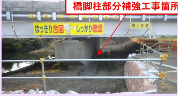
国道23号南勢バイパスにおきまして橋梁耐震補強工事を行っています南建工業株式会社です。工事は新祓川橋の左岸側の橋脚まわりに仮設の鋼矢板を打設し、橋脚巻立て補強を行います。1月も鋼矢板の打設を施工するため、鋼矢板等の材料や機械を運搬する車が入り出る予定です。工事中は、沿線及び地域住民の皆様にはご迷惑をお掛けすることとなりますが、ご理解とご協力のほどよろしくお願い致します。
