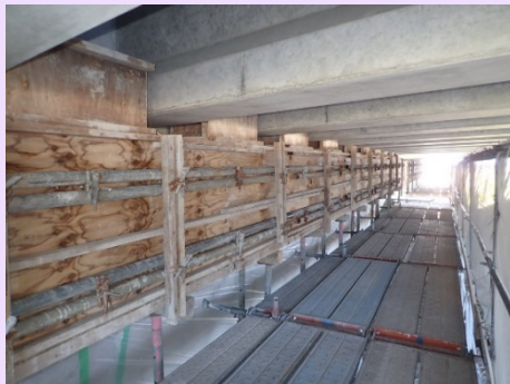
橋梁付属物工 型枠組立完了
