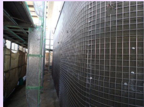
橋脚巻立て工 ラス網設置完了
