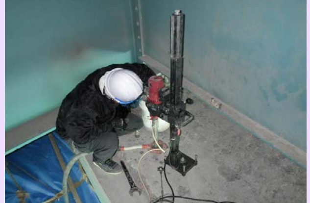
落橋防止装置（削孔状況）
