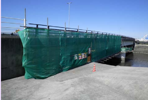
足場設置完了(A2橋台)
