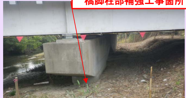
橋脚柱部補強工事箇所
