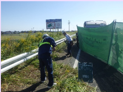
国道23号の除草作業
