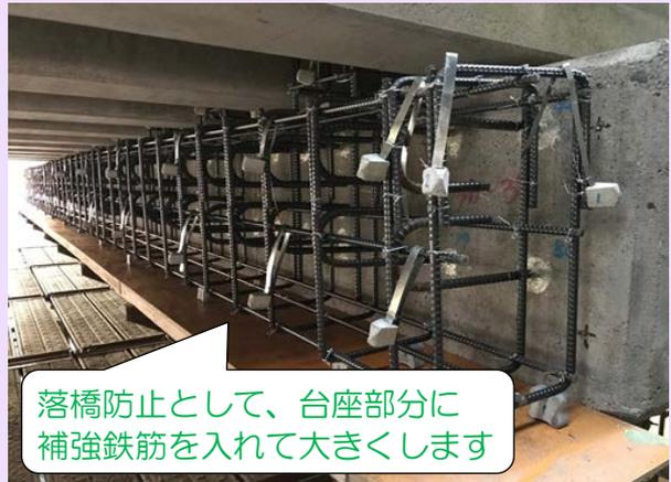
落橋防止として、台座部分に補強鉄筋を入れて大きくします
