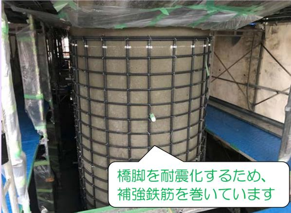
橋脚を耐震化するため、補強鉄筋を巻いています
