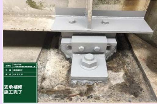
23号新愛宕橋右岸耐震補強工事を施工している株式会社 田村組です。現在、支承補修工に着手しております。支承補修工が完了し次第補修及び片付けを行い現場作業は完了となります。気温も下がり寒い時期なので、現場関係者には体調管理の徹底を周知し、もう少しで完成になりますので、今一度作業員一団となって安全作業を進めていきます。
