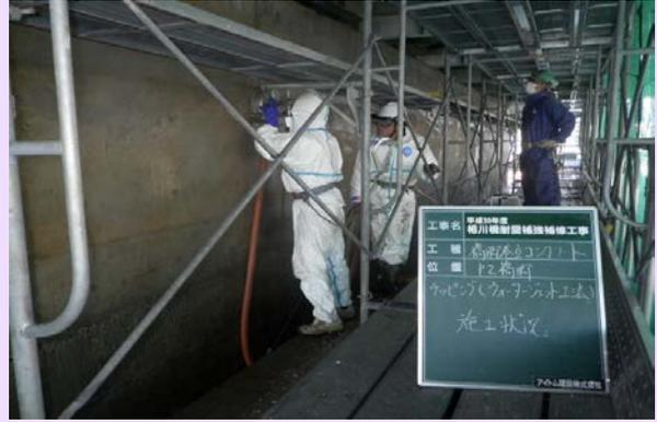
23号相川橋耐震補強補修工事を施工するアイトム建設株式会社です。現在鋼矢板打ち込みが完了し、橋脚巻立て工の施工を行っており4月末に完成する予定です。並行して3月初旬にかけて足場を設置し、ひび割れ補修、落橋防止装置工、支承取替工の調査等を行う予定です。期間中は安全第一で施工を行いますのでご理解、ご協力の程よろしくお願いいたします。
