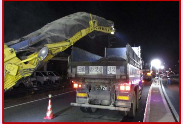
切削機(ロードカッタ)で舗装を削ります。削った舗装は長いコンベア部分を介して運ばれます。
