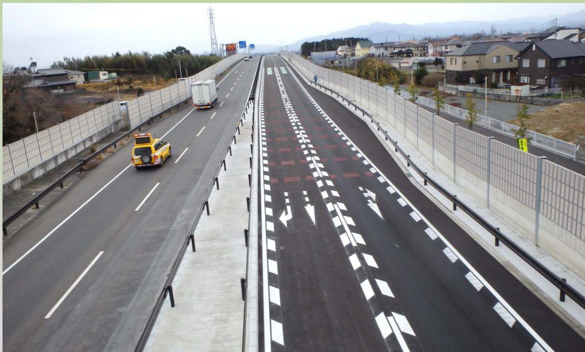
平成30年12月26日 23号BP久居野村交差点4車線化
