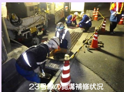
23号線の水路内補修状況
