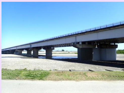
河川内完了全景
