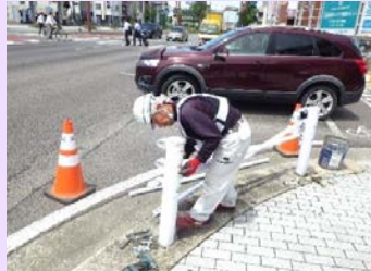
23号 津市栄町 ガードパイプの補修を行いました。
