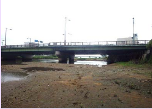
P2橋脚上流から望む
