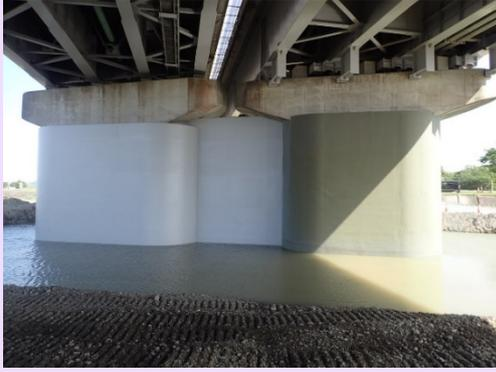
根固め工P8橋脚 根固めブロック設置完了
