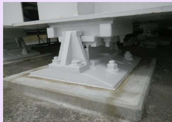
松阪東大橋(上り)線の耐震補強工事を実施している、東進産業 株式会社です。現在、支承の防錆を目的とした塗替え塗装をおこなっています。今後は、地震時の橋の落下を防ぐため、橋のかけ違い部分を連結していきます。安全には十分注意して進めていきますのでご理解ご協力の程、宜しくお願いいたします。
