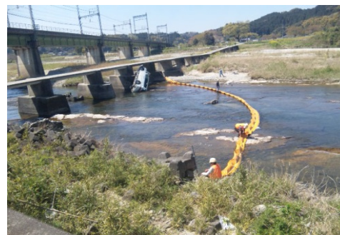
水質事故対応（交通事故による油流出）
