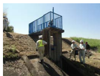
出水期前点検状況
