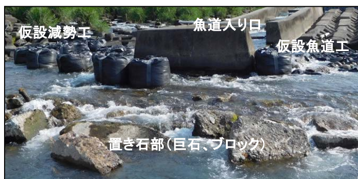
櫛田可動堰 試験施工 (平成 28 年 6 月)
