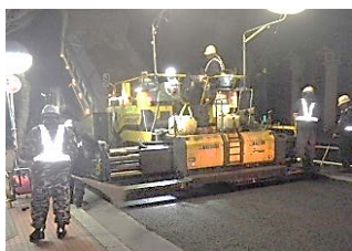
車道路面の舗装補修
