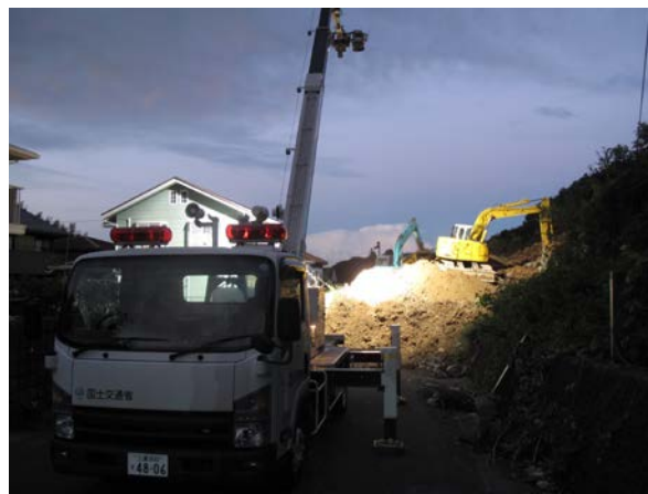
平成 27 年 9 月 10 日～12 日 台風 18 号 鳥羽市さくらが丘地区での照明車支援
