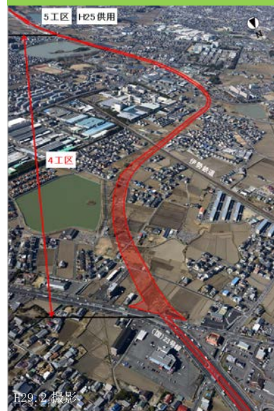
国道 23 号 中勢道路 (4 工区)
