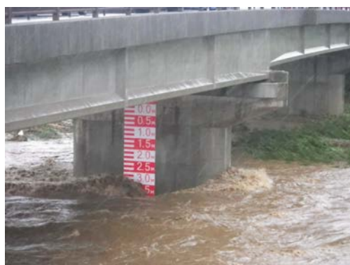
橋脚水位表示
