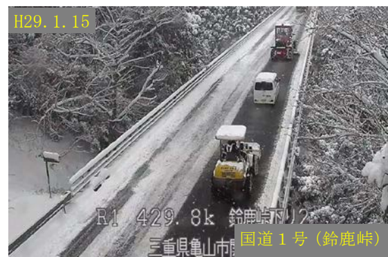
グレーダーとロードショベルを併用した除雪
