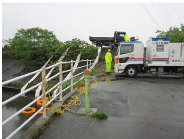
平成 27 年 5 月 12 日～13 日 台風 6 号 津市大新田排水機場での排水ポンプ車支援
