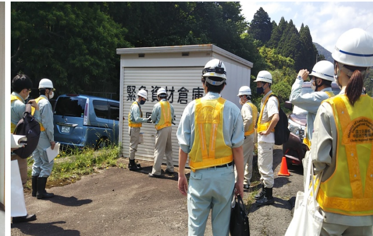
沓掛緊急資材倉庫（資材確認）
