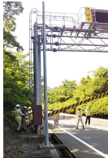
沓掛ゲート（操作訓練）
