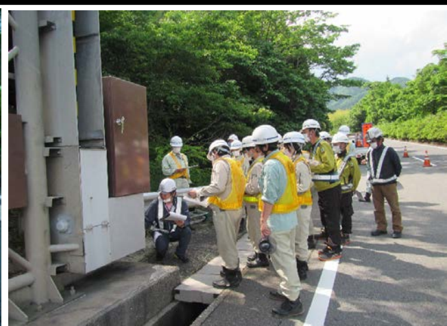
【沓掛ゲート】 遮断機操作盤の手順確認訓練
