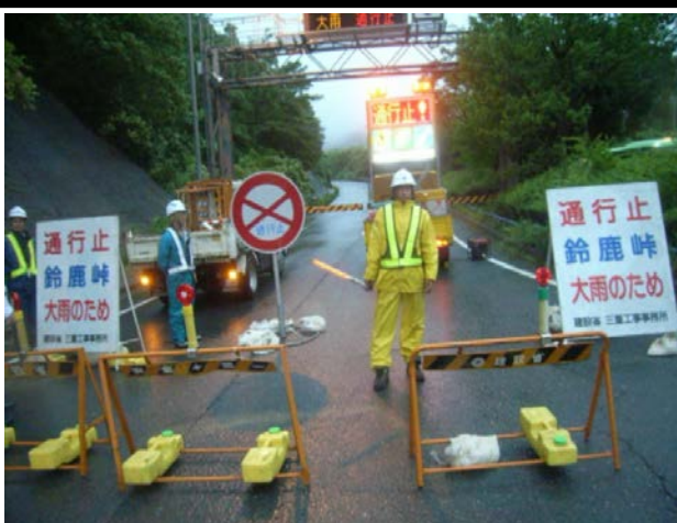
【沓掛ゲート】 大雨による通行止めの様子(H29)
