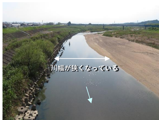
令和6年8月15日撮影 (高岡観測所の水位:-0.51m)
