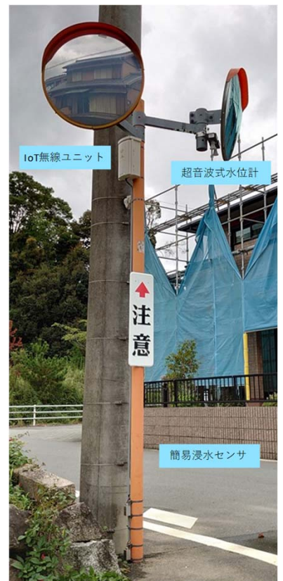
簡易浸水センサ等設置状況 (伊勢市内)
