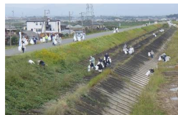
令和元年10月27日 雲出川左岸 JR雲出川橋梁付近
