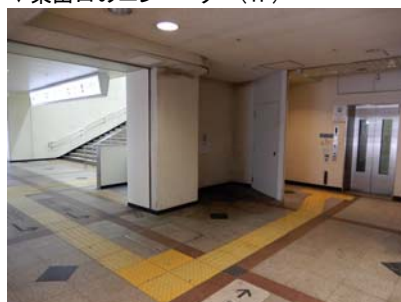
▼東出口のエレベーター(1F)
