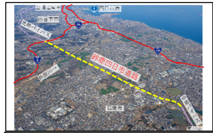
国道23号鈴鹿四日市道路 （鈴鹿市上空から四日市港方面）
