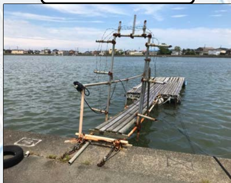
撤去対象棧橋①
