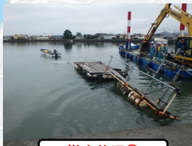
撤去状況①
