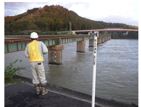
河川状況確認 (JR櫛田橋橋梁)
