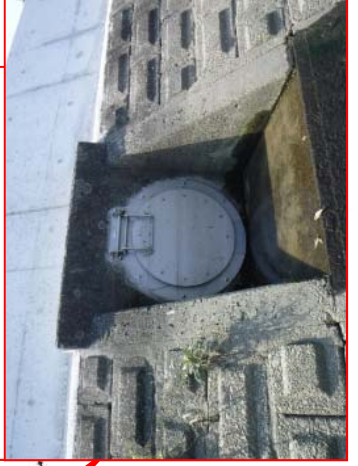
【伊勢市】逆流防止フラップ弁設置 (勢田川7箇所、8月完了)
