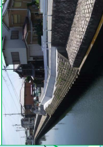
【国】緊急的な堤防かさ上げ (勢田川 北新橋付近 右岸24m、6月完了)
