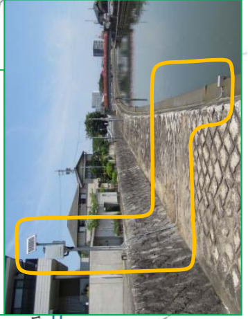
【国】危機管理型水位計の設置 (勢田川1箇所、3月完了)
