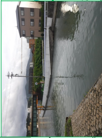
【国】緊急的な堤防かさ上げ (勢田川 JR参宮線付近 左岸95m 右岸94m、9月完了)
