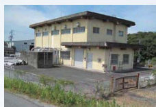
汁谷川排水機場
