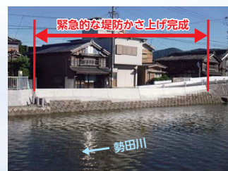
特殊堤防設置状況 (北新橋右岸下流)
