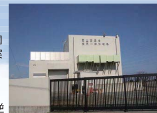
桧尻川排水機場ポンプ増強
