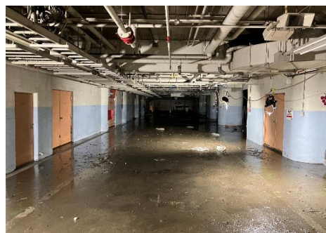
地下2階浸水解消状況
