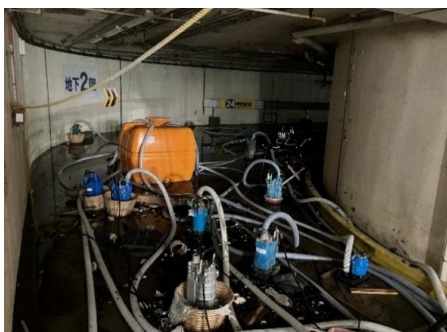
地下2階ポンプ排水作業状況
