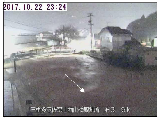
○西山橋付近出水状況
