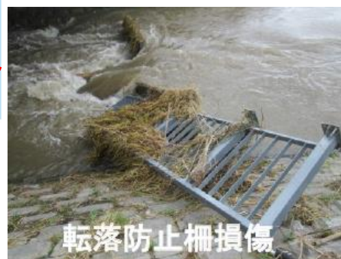
右: 転落防止柵損傷 雲出川 左岸8.2k
