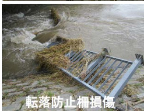
右: 転落防止柵損傷 雲出川 左岸8.2k
