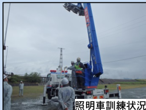
照明車訓練状況
