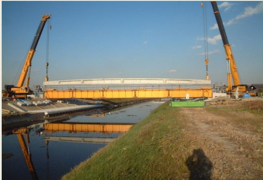
大型クレーン2台による架設(例)
