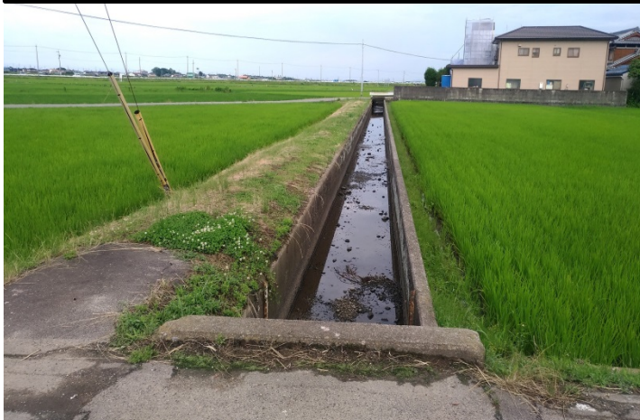
農業用水路の末端まで水が行き届いていない状況(H29.6.28)
