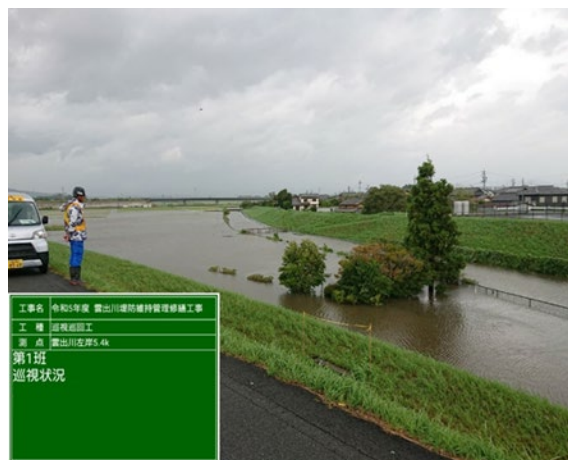
雲出川左岸5.4k 付近
