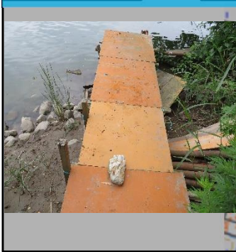
撤去対象栈橋: (非公開)
