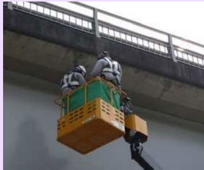
高所作業車による橋梁点検
