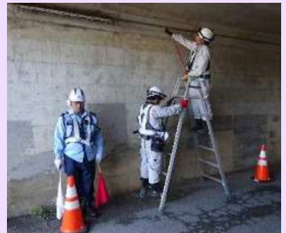
脚立によるカルバート点検
