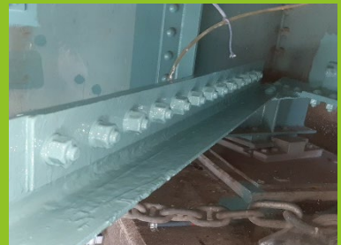
橋梁補修工事で板補修
