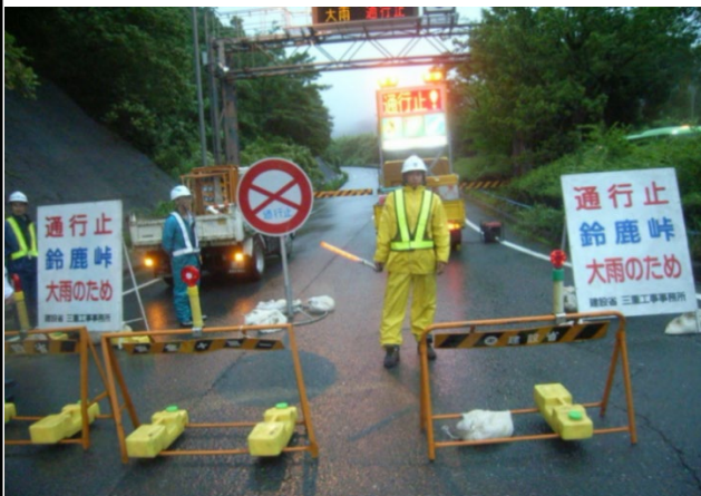
【沓掛ゲート】 大雨による通行止めの様子
