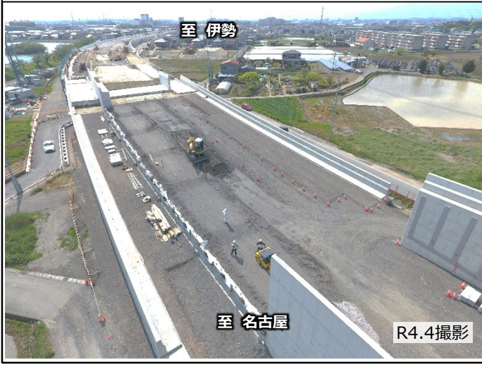
②玉垣地区において改良工事を推進中
