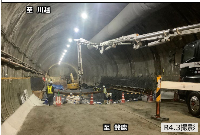
①坂部トンネル工（鈴鹿側）を推進中
