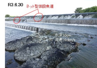
袋詰め玉石による段差解消
