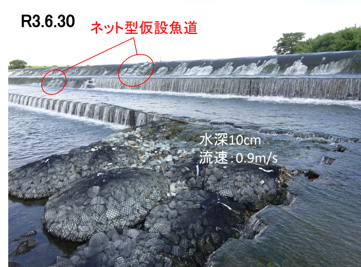
袋詰め玉石による段差解消
